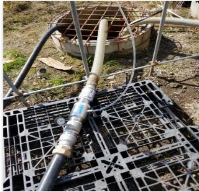
OKノズル設置 (井戸手前)
